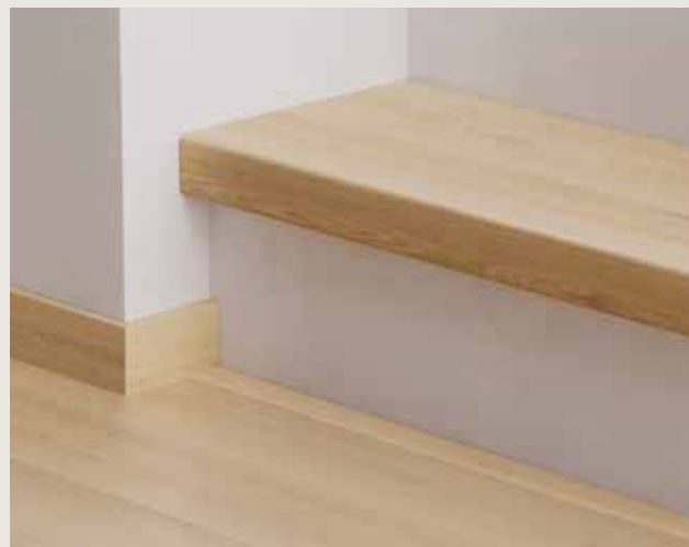
MONTAŻ PODSTOPNI PRZEZNACZONYCH DO MALOWANIA Wystarczy zakryć stopień i pomalować resztę na taki sam kolor co ściana.
